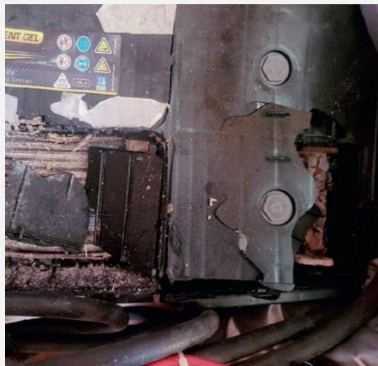
Overbelastning af batteri
