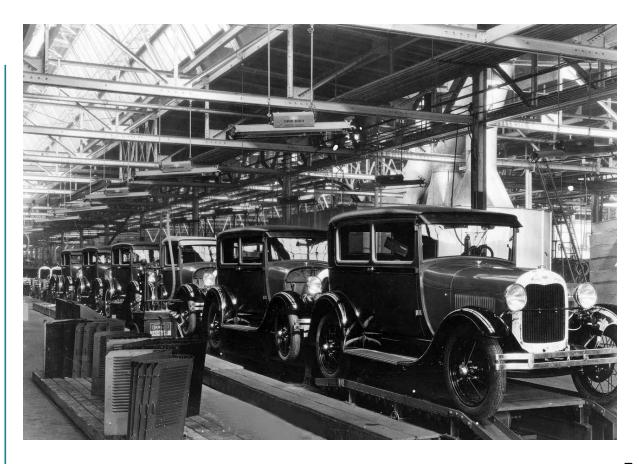
Standardisierte Bauteile + standardisierte Prozesse → Im Jahr 1908 kostet ein "Model T" noch 850 US-Dollar. Nach der Einführung des Fließbands sinkt der Preis auf 300 US-Dollar.
